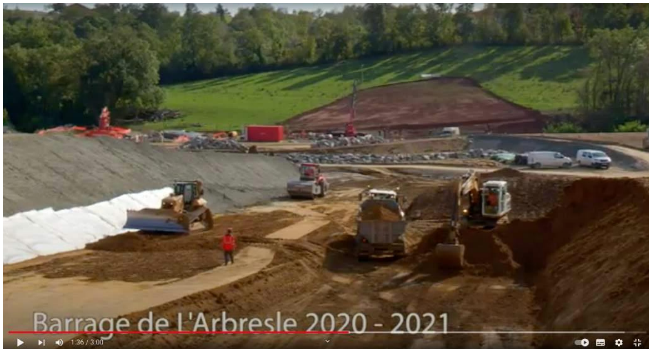
Chantier de l'ouvrage de l'Arbresle - Vidéo SYRIBT 37
