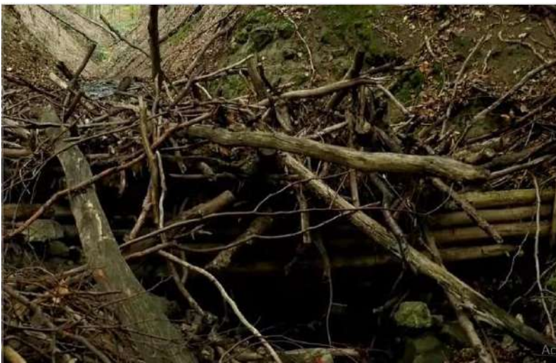
FIGURE 16 : GROS EMBACLES DANS UN BARRAGE EN BOIS
